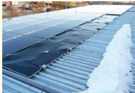
Montagefehler/Schneelastschaden
