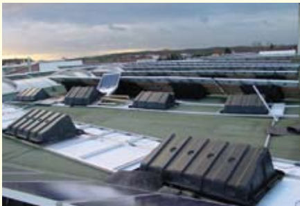
Montagefehler/Sturmschaden
