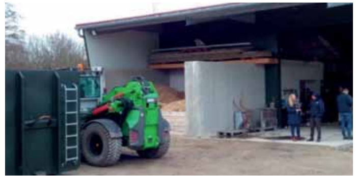
Die Biogasanlage wurde um eine Holzheizzentrale in unmittelbarer Nähe der Trocknungsanlage ergänzt.
