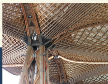
Wykorzystanie drewna konstrukcyjnego
