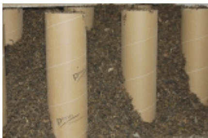
"Sandwichaufbau" der Bodendämmung
