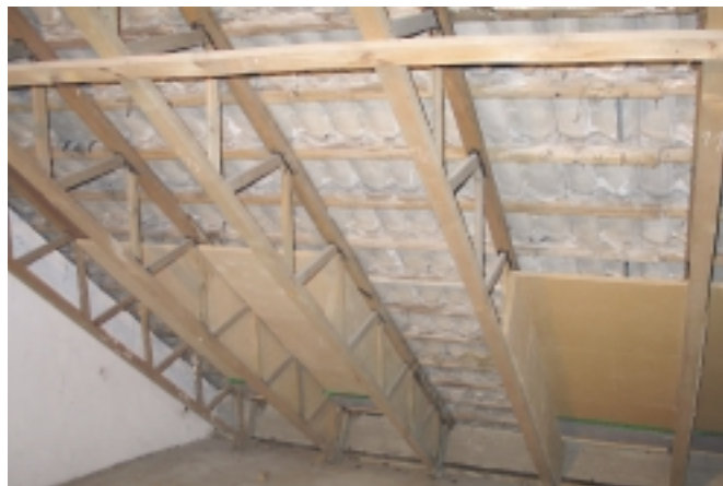
ungedämmer Dachbereich
