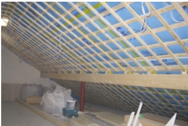
Dachbereich mit Zwischensparrendämmung
