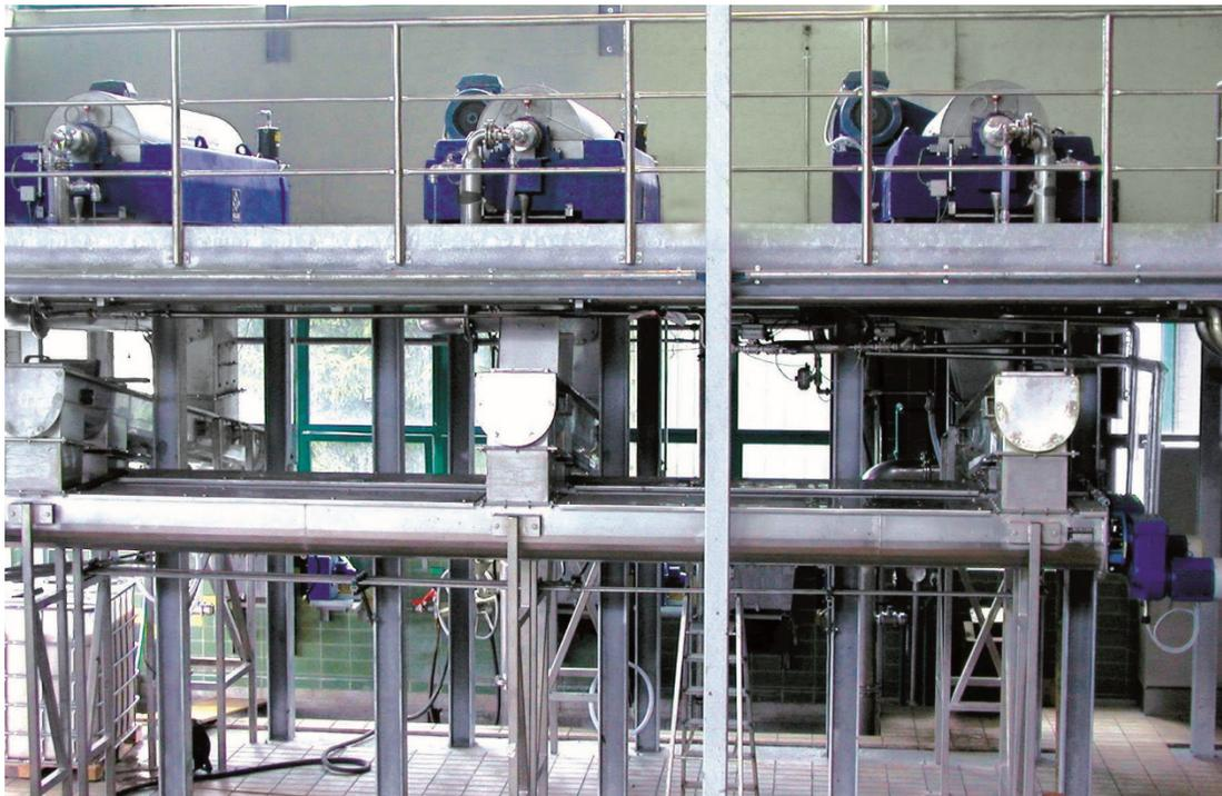
Hiller-Dekanter werden zur industriellen und kommunalen Abwasserreinigung eingesetzt
