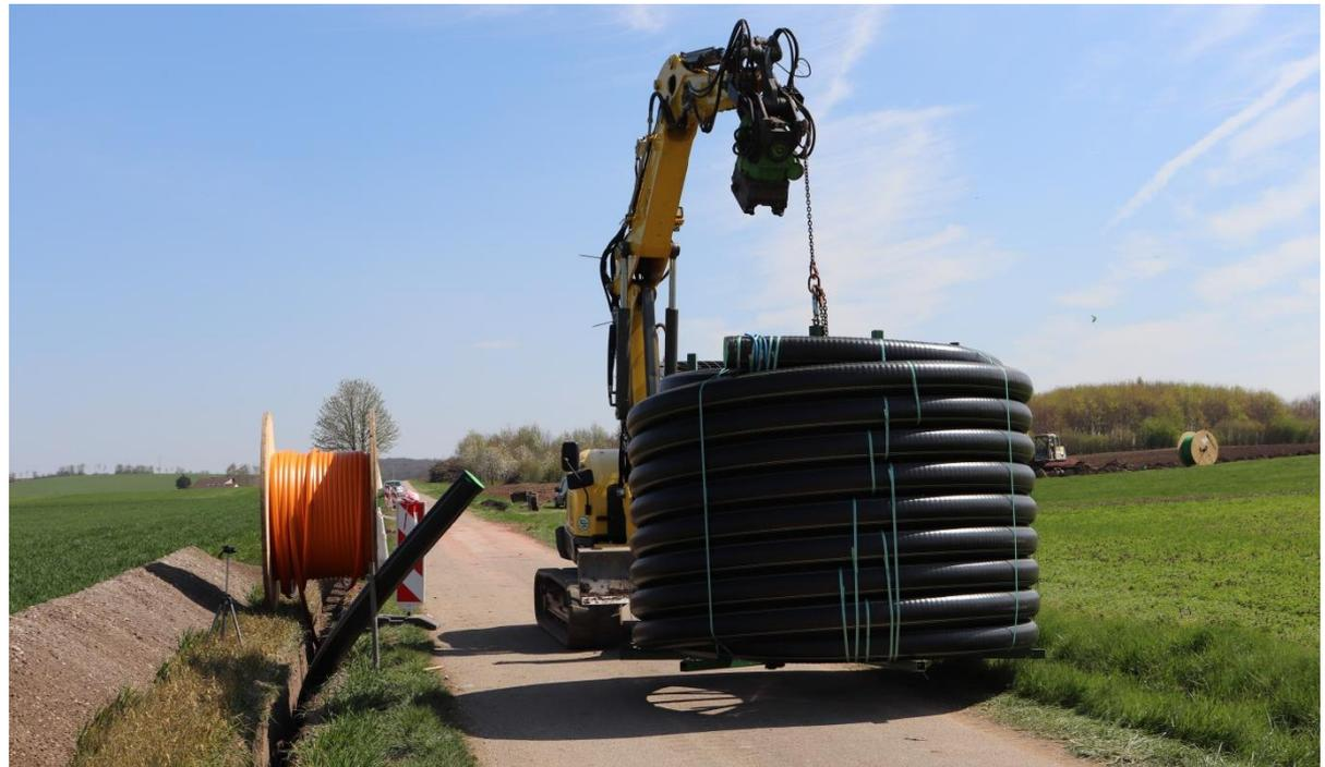
Grabenfräse + Verlegung der Wärmerohre
