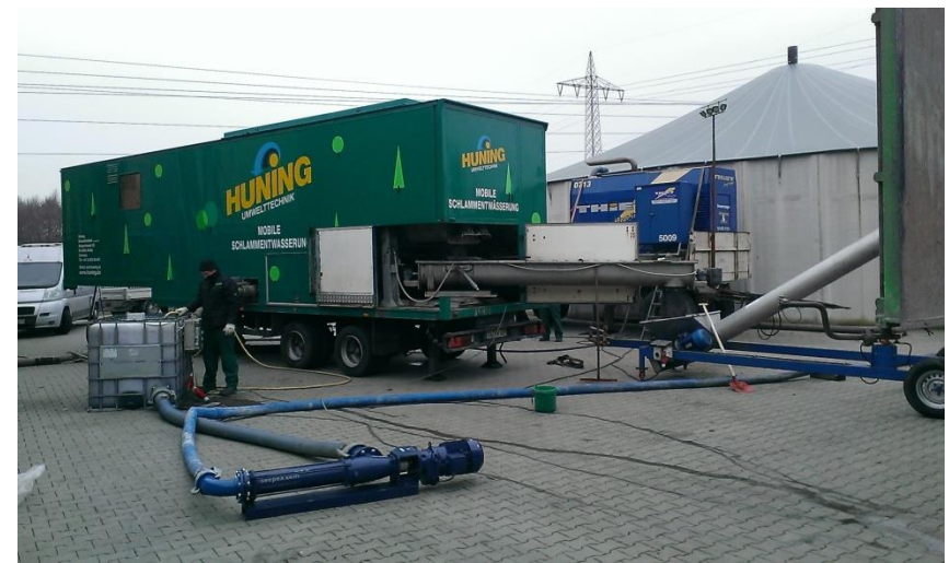
2.+ 3. Einsatz 2015, Leistung 30m 3 /h
