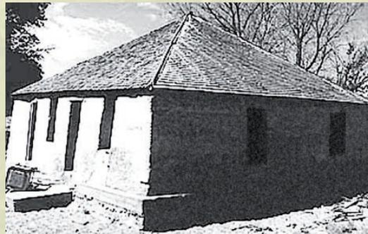
Der älteste lasttragende Strohballebau: Das Burke-Haus (Nebraska) wurde 1903 erbaut und steht heute noch. Die Ballen bilden ein geschlossenes Wandsystem und tragen die Last des Daches komplett ab.
