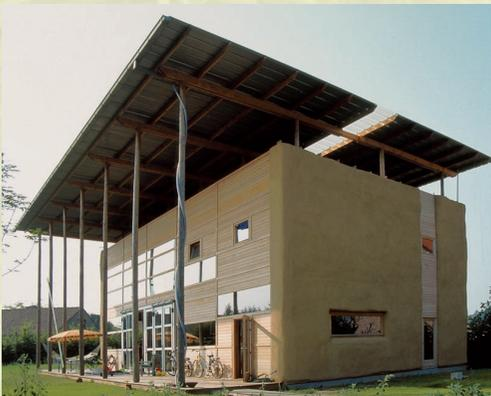
Der Architekt Herwig van Soom hat dieses Haus in Blanden (Belgien) für sich und seine Familie entworfen. Das große Flugdach bietet genügend Schutz für den Lehmputz. Vor einer tragenden Rundholzständerkonstruktion wurde eine durchgehende Wärmedämmschicht aus Strohbällen errichtet.
